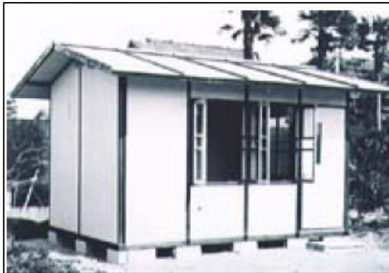
รูปที่ 5-13 Mizet House บ้านที่ก่อสร้างด้วยเทคโนโลยีโครงสร้างสำเร็จรูปรุ่นแรก ๆ
