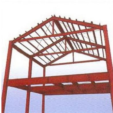
รูปที่ 5-7 เทคนิคการสร้างบ้านโครงเหล็กระบบ Rahmen
