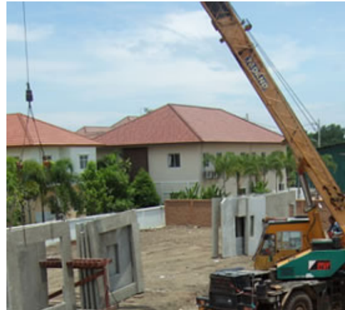
รูปที่ 5-9 เทคนิคการก่อสร้างด้วยเทคโนโลยี Precast และ Prefabricate
