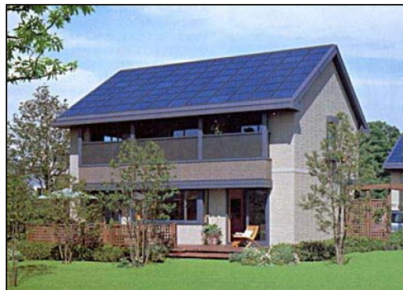
รูปที่ 5-14 Misawa Home Z บ้านที่ก่อสร้างด้วยเทคโนโลยีโครงสร้างสำเร็จรูปที่เสริมด้วยระบบ PV Solar Home
